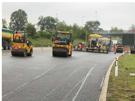
Mise en œuvre d'enrobés recyclés (Bülach-Kloten, canton de Zürich).
